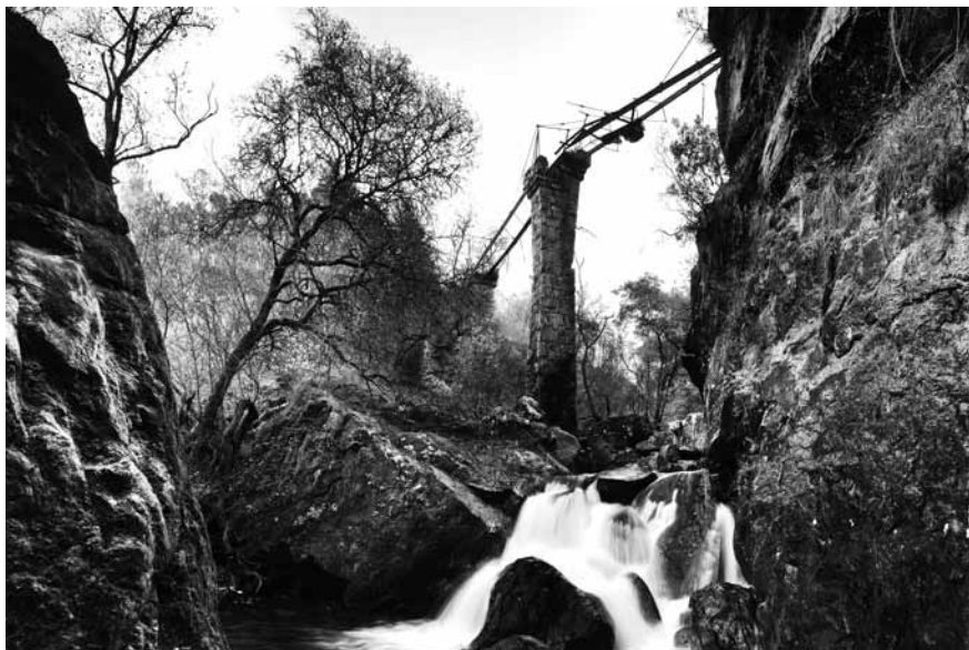
Viaducto do barranco de Pina sobre o río Liñares.
