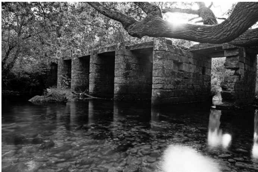
Ponte do Portón en San Miguel de Arca.
